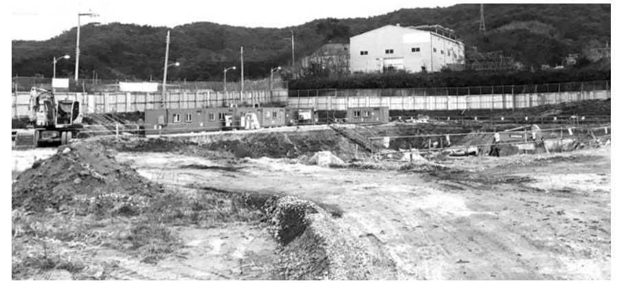
순창 풍산면 풍산 제2 농공단지 내에 조성 중인 순창변전소.
