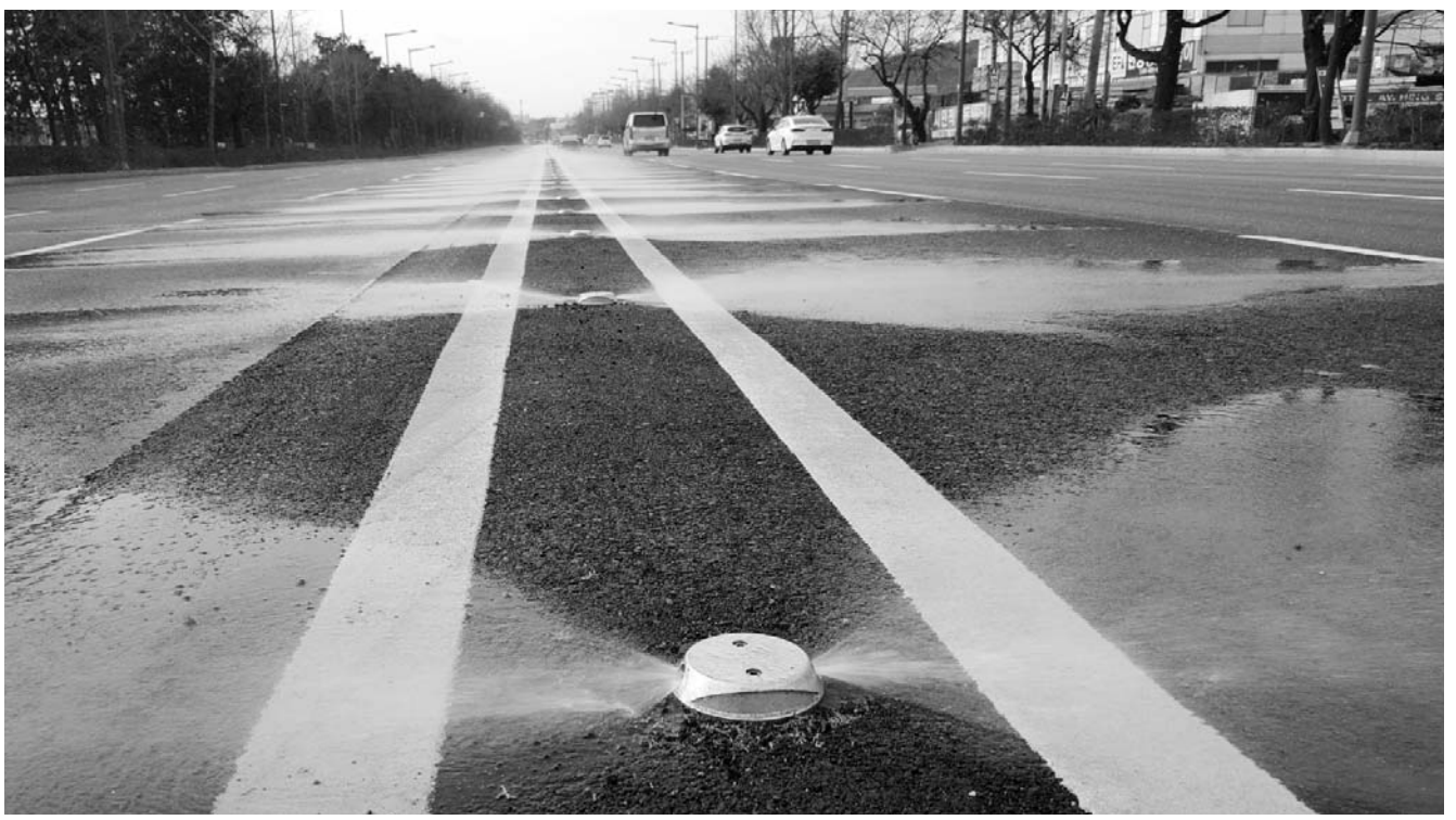
극락교~광주송정역 구간에 설치된 클린로드 시스템.
