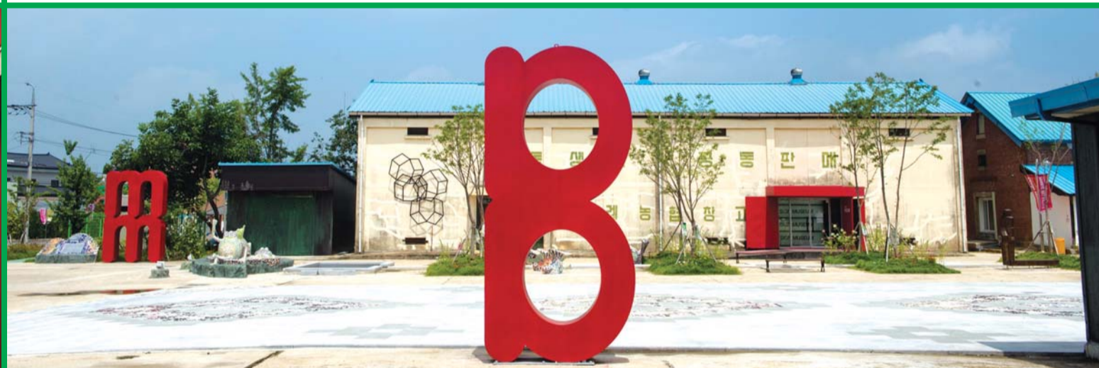
일제강점기의 양곡창고를 리모델링한 삼례문화예술촌의 전경.
