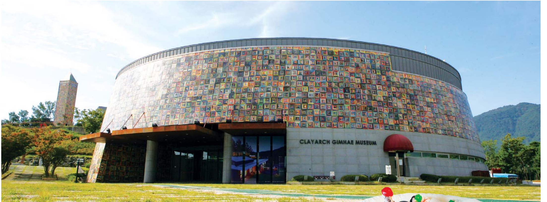
클레이아크 김해미술관의 돔 하우스 외벽은 5000장의 사각형 타일(48x48cm)로 마감돼 화려하면서도 역동적인 느낌을 준다. 타일을 구워서 제작한 외벽(Fired Painting)은 미술관의 소장품 1호이기도 하다. <사진:클레이아크 김해미술관>
