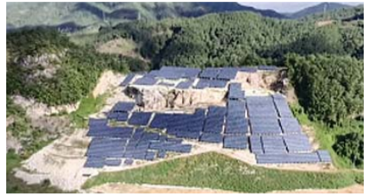
태양광 발전소 전경
