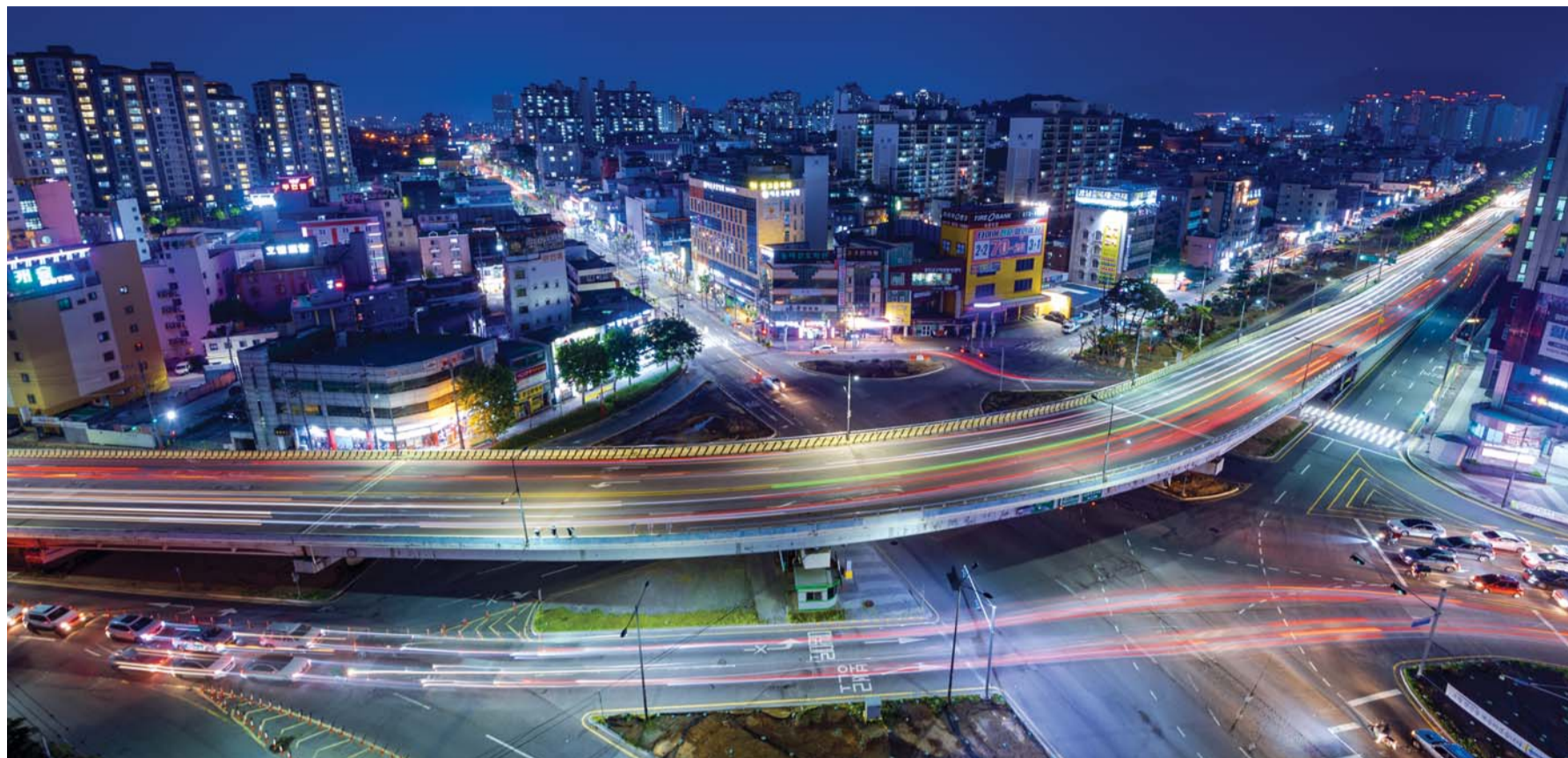
1989년 11월 개통된 백운고가 차도가 31년만에 철거된다. 4일부터 철거될 백운고는 길이 385.8m, 폭 15.5m로 백운동에서부터 주월동까지 도심을 연결하는 다리 역할을 해왔다. 도시철도 2호선 공사와 백운고가 차도 철거 공사까지 맞물리면서 광주의 주요 교통 라인이 백운광장 인근의 교통대란이 현실화될 것으로 보인다. /김진수 기자 jeans@
