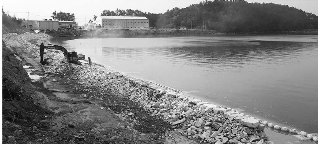
해양수산부의 '노력도 도서종합개발 사업'이 지지부진하면서 장흥 노력항 선망어업 선단 거점 전진기지 유치가 물거품이 되지 않을까 우려된다. 사진은 '노력도 종합개발 사업' 중 일주도로 공사 현장.
