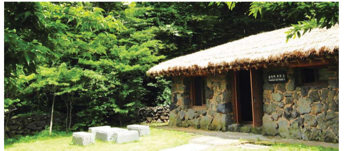
초가 모양으로 설치된 교래휴양림의 숙박시설.
