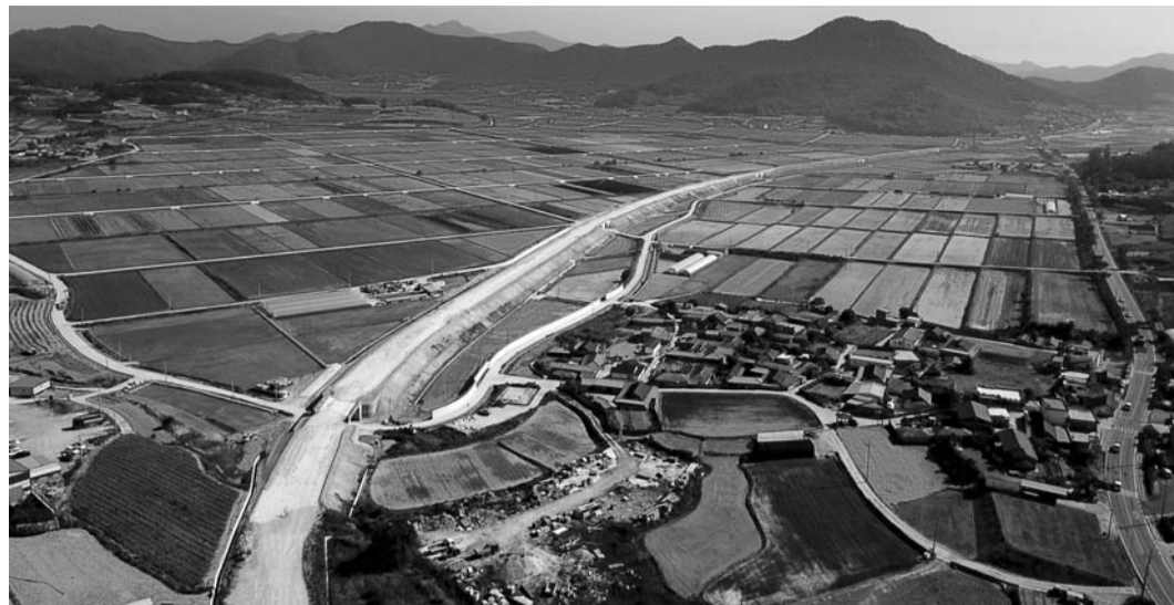
진도군이 2024년까지 1800억원을 투입해 SOC 개발 사업을 추진한다. 사진은 국도18호선 도로 확장 공사 현장. (진도군 제공)
