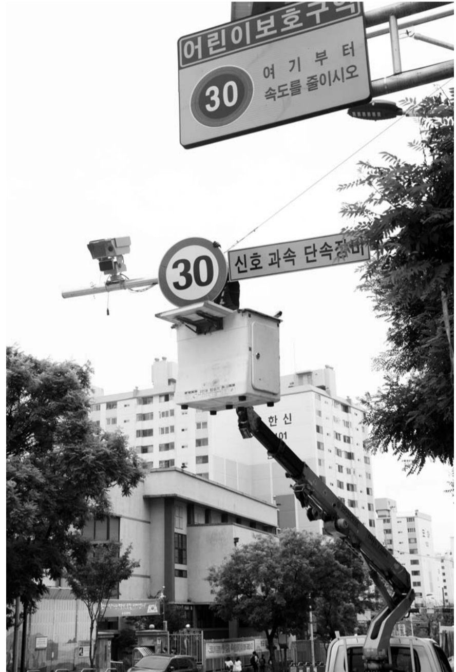
어린이보호구역 CCTV 설치 17일 광주시 북구 문산초등학교 사거리 어린이보호구역에서 북구청 시설지원과 직원들이 속도제한 표지판과 과속단속장비(CCTV)를 설치하고 있다. /최현배 기자choi@
