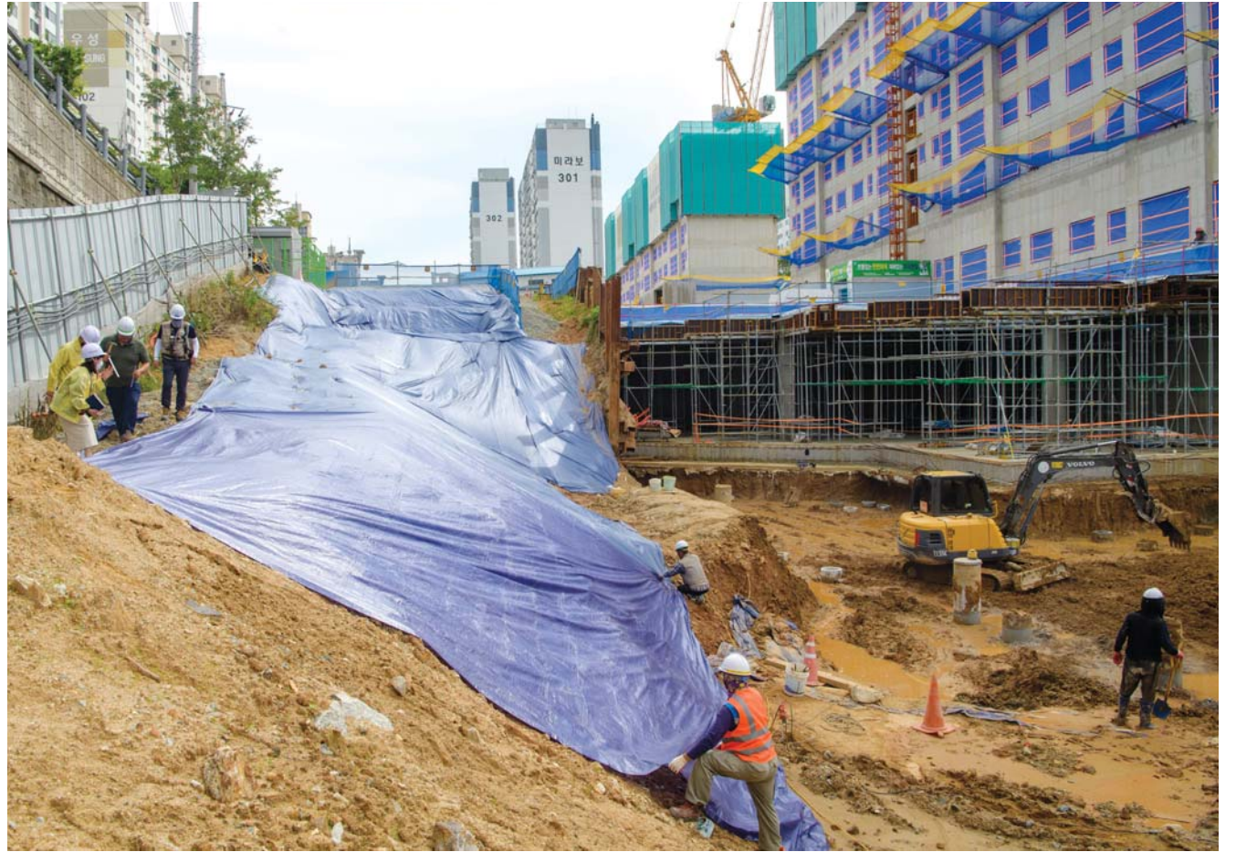
장마 대비 방수포 설치 23일 광주 북구 한 아파트 건설현장에서 작업자들이 장마를 대비해 토사 등이 쌓인 절개지에 방수포를 덮고 있다. /김진수 기자 jeans@kwangju.co.kr
