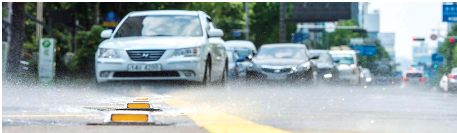
금남로 식히는 클린로드 시스템 광주 낮 기온이 31도를 보인 23일 오후 광주시 동구 금남로에 설치된 클린로드 시스템이 작동해 도로를 식혀주고 있다. 클린로드 시스템은 도로 중앙분리대에 설치한 노즐을 통해 지하수를 도로 위에 뿌리는 친환경 시스템이다. /최현배 기자choi@kwangju.co.kr
