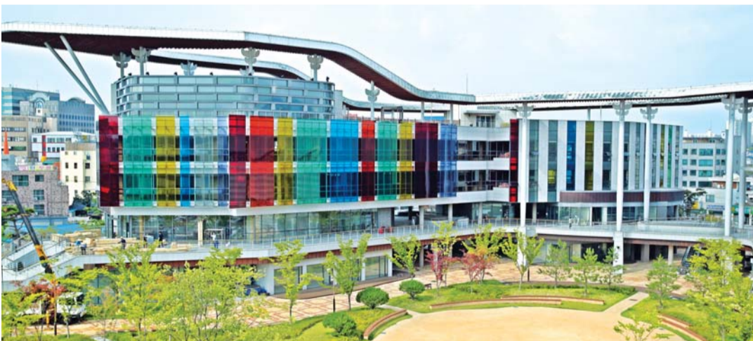
유네스코 음식창의도시의 거점공간인 한국전통문화전당 전경.
