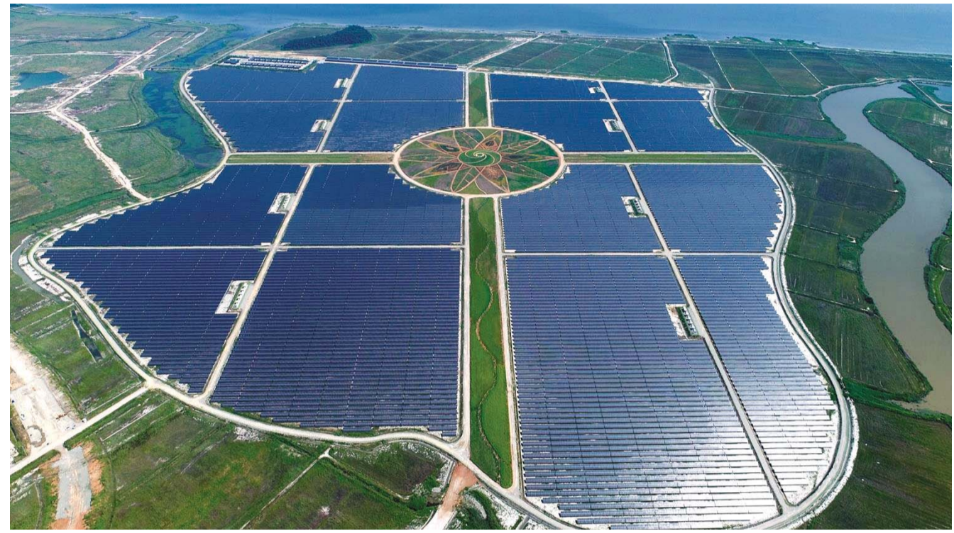
29일 전남도와 한양 등에 따르면 최근 준공된 솔라시도 태양광발전소가 국내 최대 규모인 98MW급의 태양광 발전설비와 세계 최대 용량인 306MWh급의 에너지 저장 장치(ESS)를 갖췄다. /연합뉴스
