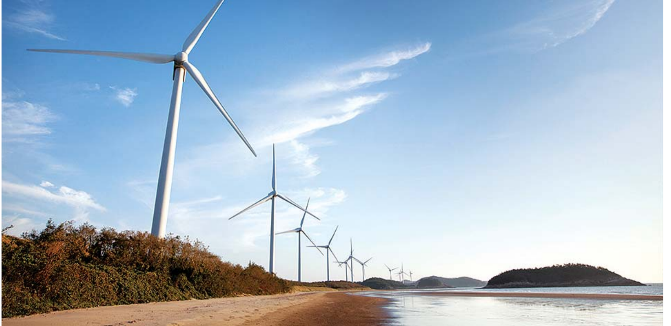
포스코에너지가 신안군 자연면 일대에 만든 62.7MW 규모 육상풍력발전단지.
