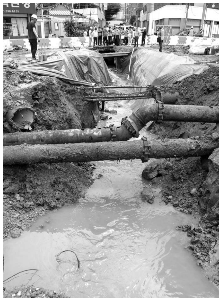
폭우 대비해 만든 배수로 정밀비로 상습 침수피해가 발생한 광주 중흥 3구역 재개발 공사현장 부근 도로에서 5일 오전 폭우에 대비해 공사 관계자들이 배수로를 만든 뒤, 축대를 방수포로 덮고 있다.
