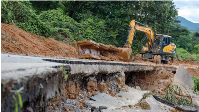
유실 도로 복구 9일 오후 담양 금성면의 한 지방도가 토사와 빗물 등으로 유실되어 담양군청 건설과 직원들이 복구작업을 벌이고 있다.
