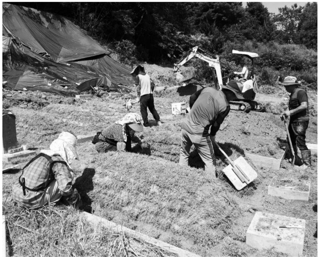
광주도시공사 직원 호우피해 망월묘지공원 복구 '구슬땀' 광주도시공사 직원들이 집중호우 피해를 입은 망월묘지공원 복구 작업에 구슬땀을 쏟아내고 있다. 망월묘지공원은 산사태로 일부 토사가 흘러들면서 140여기의 묘지가 피해를 입었으며, 이달 내 마무리를 목표로 연휴기간에도 휴일 없이 중장비와 작업인원을 대거 투입했다는 게 도시공사의 설명이다.
