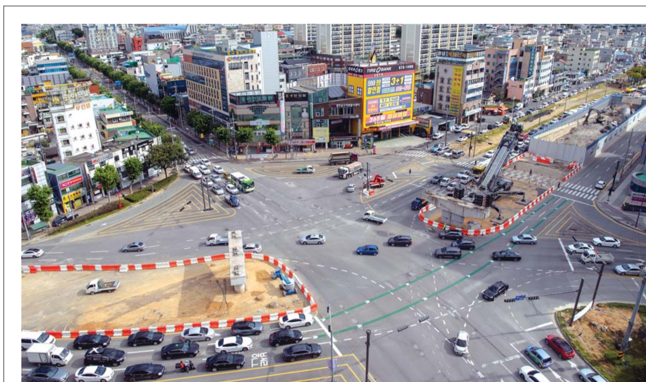
광주 백운고가 상판 구조물 철거 완료 23일 오전 광주 남구 백운고가차도의 마지막 남은 상부 구조물이 철거됐다. 광주도시철도본부건설분부는 다음 달부터 우벽 등 잔재를 해체작업에 돌입, 어는 11월까지 철거 공사를 마무리할 방침이다. 지난 1989년 11월 길이 385.8m, 폭 15.5m로 개통된 백운고가차도는 백운동부터 주월동까지 도심을 연결하는 다리 역할을 해왔다. /김진수 기자 jeans@kwangju.co.kr
