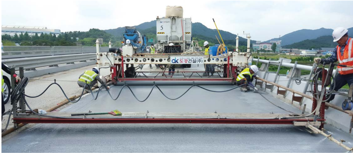
도경건설은 국내 자연환경에 맞춰 기존 도로포장의 문제점을 개선하기 위해 꾸준히 기술 개발에 나서고 있다. 도경건설 직원들이 고성능 개질 콘크리트 시공을 하는 모습.
