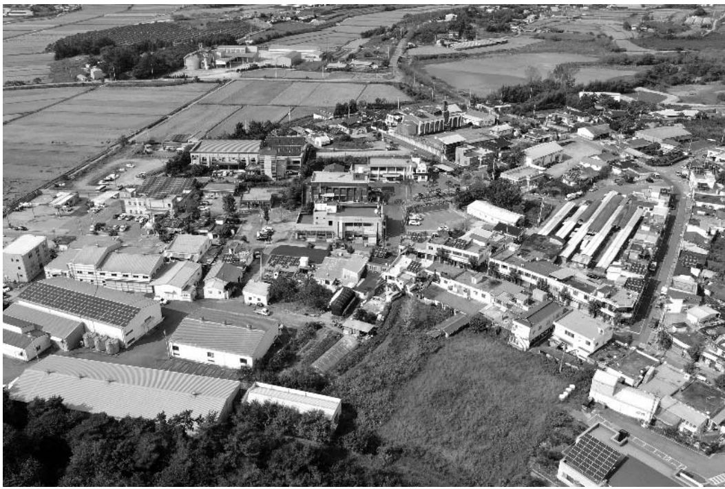
에너지자립마을 사업이 추진 중인 나주시 공산면 일대 주택과 건물 지붕 곳곳에 태양광 발전용 패널이 설치돼 있다. <나주시 제공>
