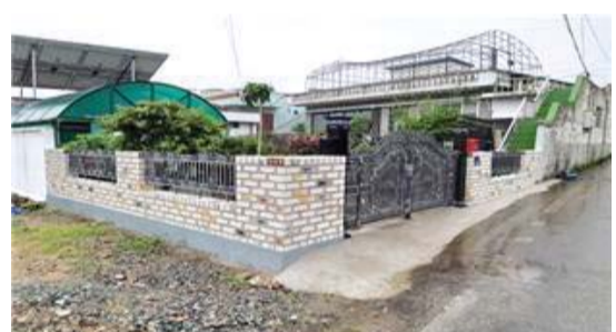
강진읍 동성리 일원 노후주택 정비 공사 전(위)과 후 모습.
