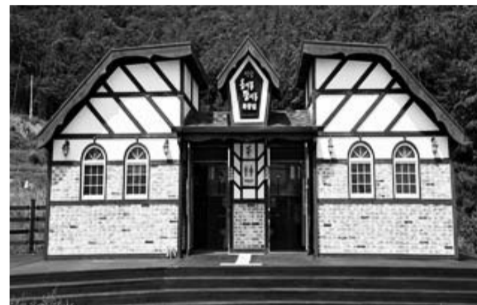
해남군 ‘땅끝 읍시룡감시룡 화장실’.
