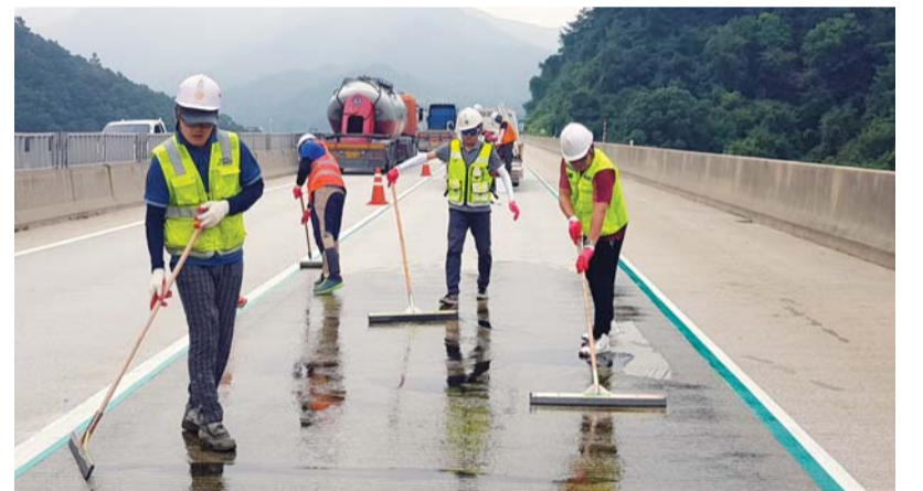
도경건설 직원들이 '불투수 차단층(샌드구스) 공법'을 적용해 시공하는 모습(왼쪽)과 'DK-Sealer' 공법으로 시공을 하고 있는 모습.
