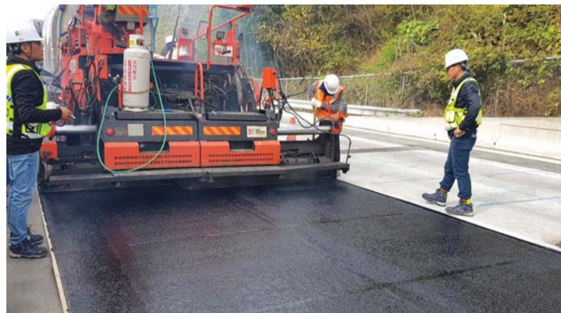
도경건설 직원들이 '불투수 차단층(샌드구스) 공법'을 적용해 시공하는 모습(왼쪽)과 'DK-Sealer' 공법으로 시공을 하고 있는 모습.
