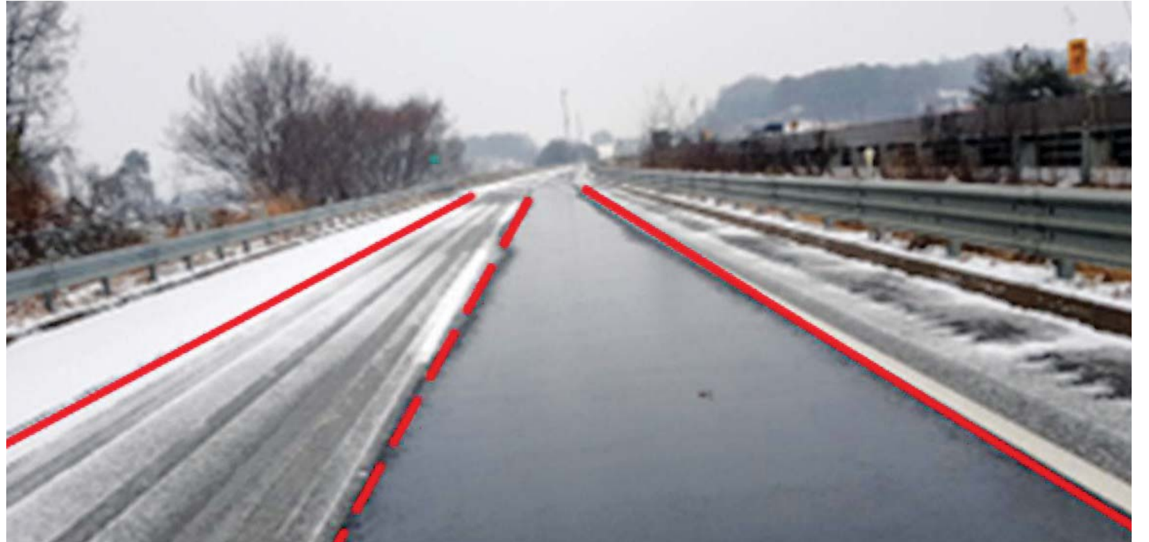
도경건설의 특허가 적용된 '결빙방지 표면처리공법'으로 시공한 구간(오른쪽)은 눈이 녹아 있는 반면, 시공하지 않은 구간(왼쪽)은 눈이 쌓여 있다. 해당 공법은 겨울철 도로 살얼음으로 인한 미끄럼 사고를 방지할 수 있는 기술로, 영하 6℃까지 살얼음 방지, 3년 이상 지속성, 염화칼슘에 의한 금속 부식 예방과 환경오염 저하 효과 등을 갖췄다.
