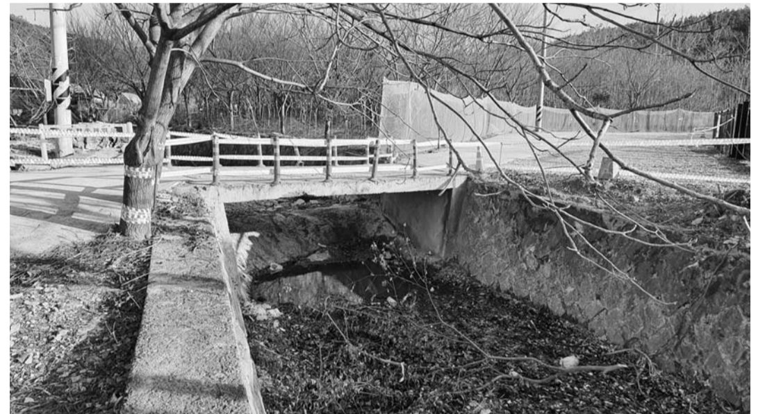
나주시는 교량 길이 5m의 포림천교를 20m로 늘려 특수공법을 이용해 포림천교를 재가설할 예정이다. /나주=손영철 기자 yacson@
