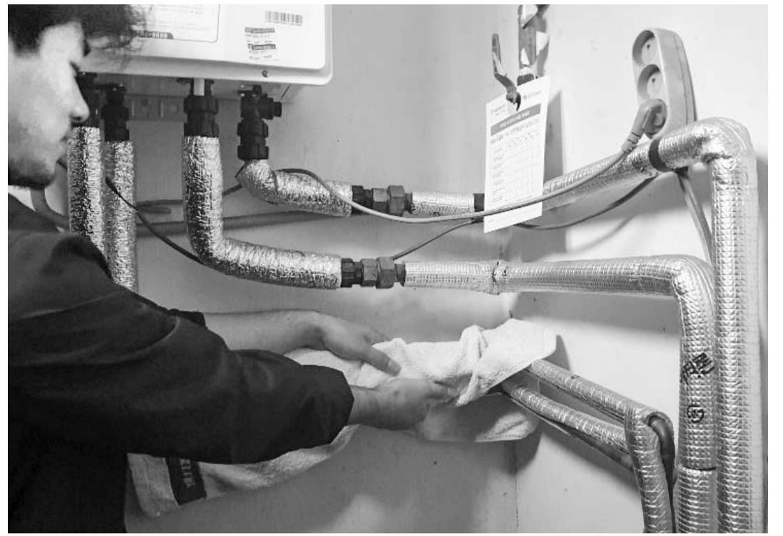
폭설과 한파로 광주지역에서 수도관과 보일러 배관이 얼어 물이 나오지 않거나 터지는 동파사고가 이어진 가운데, 10일 오전 광산구 한 아파트의 주민이 얼어붙은 보일러 배관을 뜨거운 물수건으로 녹이고 있다. /최현배 기자 choi@kwangju.co.kr
