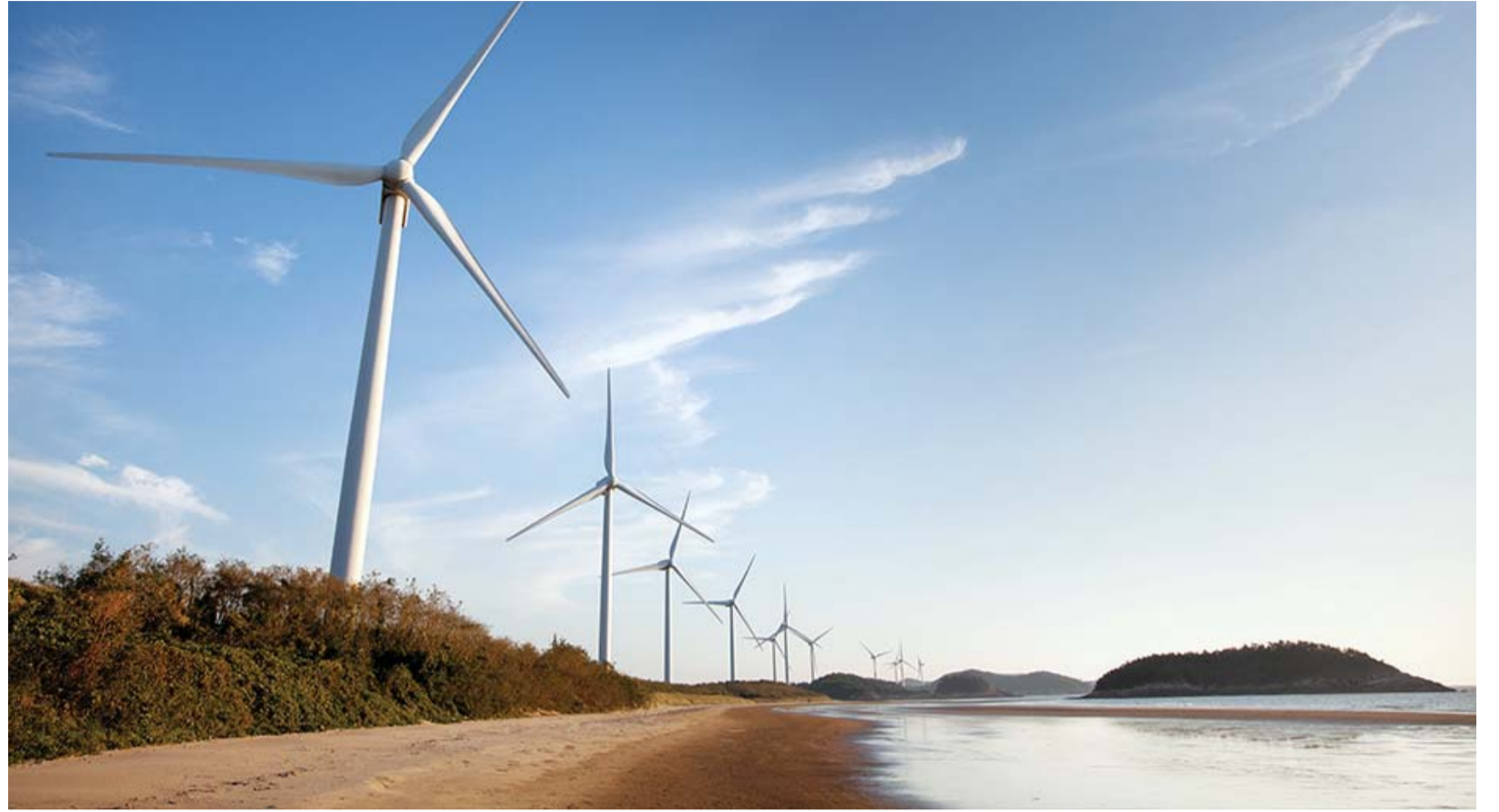
포스코에너지가 신안군 자문면 일대에 만든 62.7MW 규모 육상풍력 발전단지.
