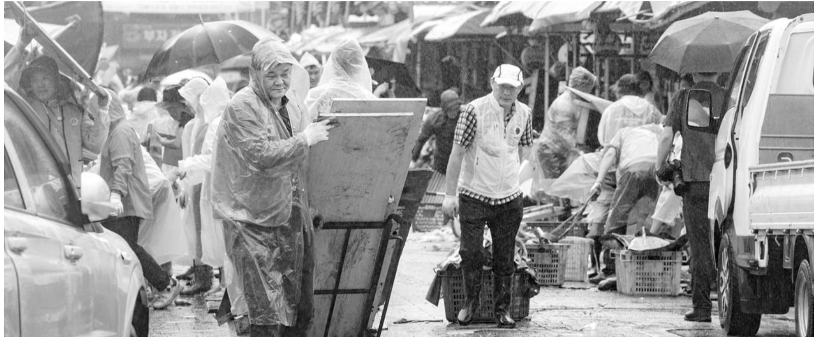
지난해 8월 집중호우로 사상 최악의 수해를 입은 구례군이 정부 및 기관·단체 지원금 3657억원을 투입해 공공시설 및 사유시설 지원 복구에 나선다. 지난해 8월 폭우에 이은 태풍 '장미'로 인해 비바람이 부는 가운데 구례5일시장에서 자원봉사자들이 수해 복구에 구슬땀을 흘리고 있다. <광주일보 자료사진>
