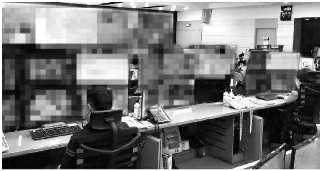
광주시CCTV통합관제센터의 내부 모습.
