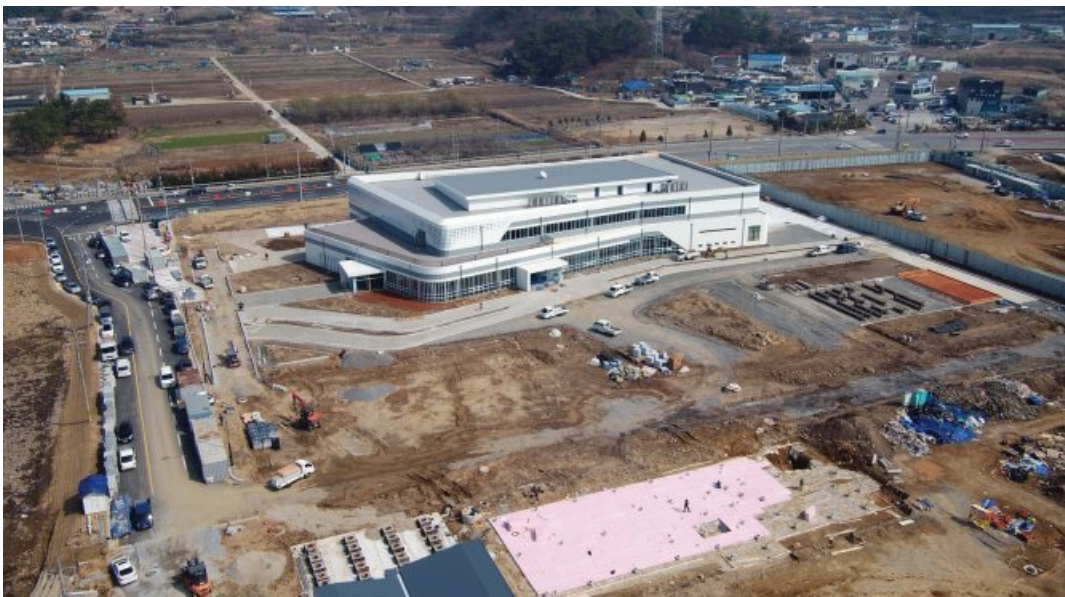
공사가 한창인 순천만잡월드.
