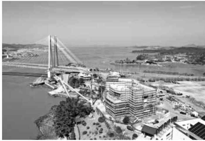
케이블카·스카이워크 공사 중인 우수영 전경.
