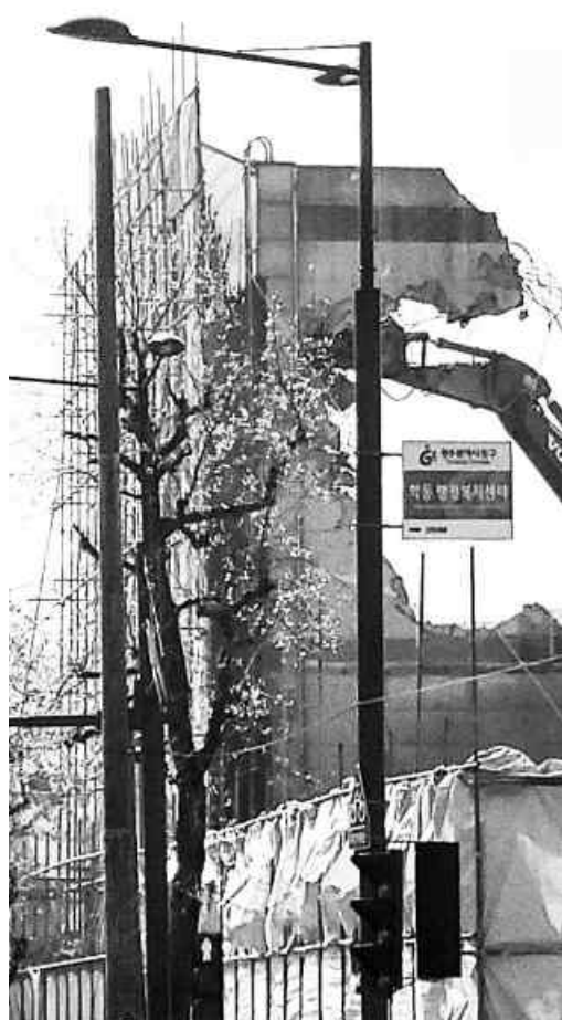
광주시 동구 학동 4구역 재개발 사업지에서 붕괴 참사가 일어나기 전 인근의 다른 건물해체 공사 모습. 최고층부터 차례대로 철거해 내려가는 일반적인 방식과 다르게 진행되고 있다. <독자 제공>
