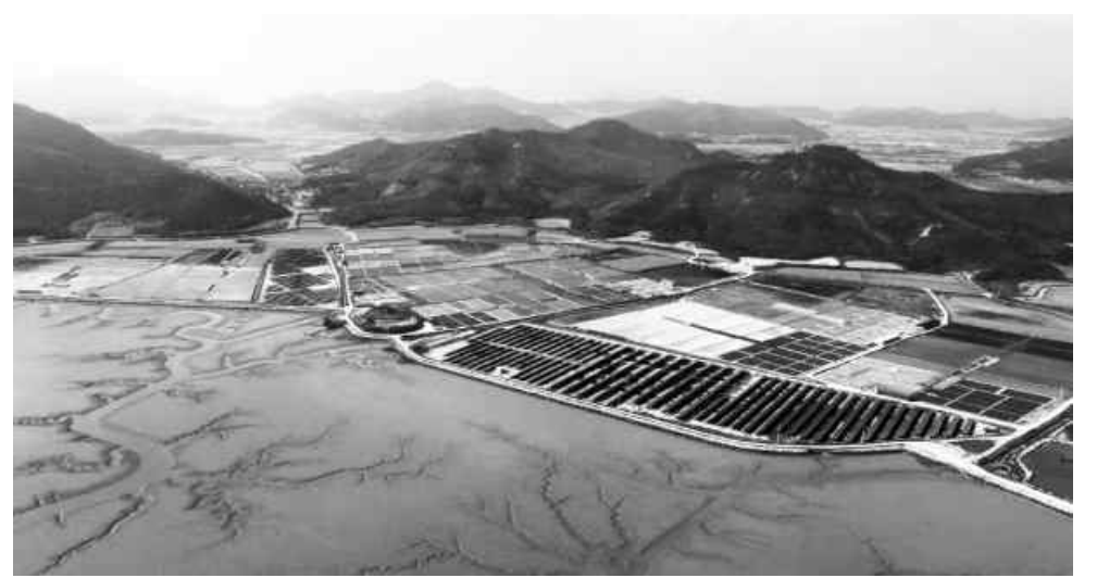
도초 도락방조제 전경
