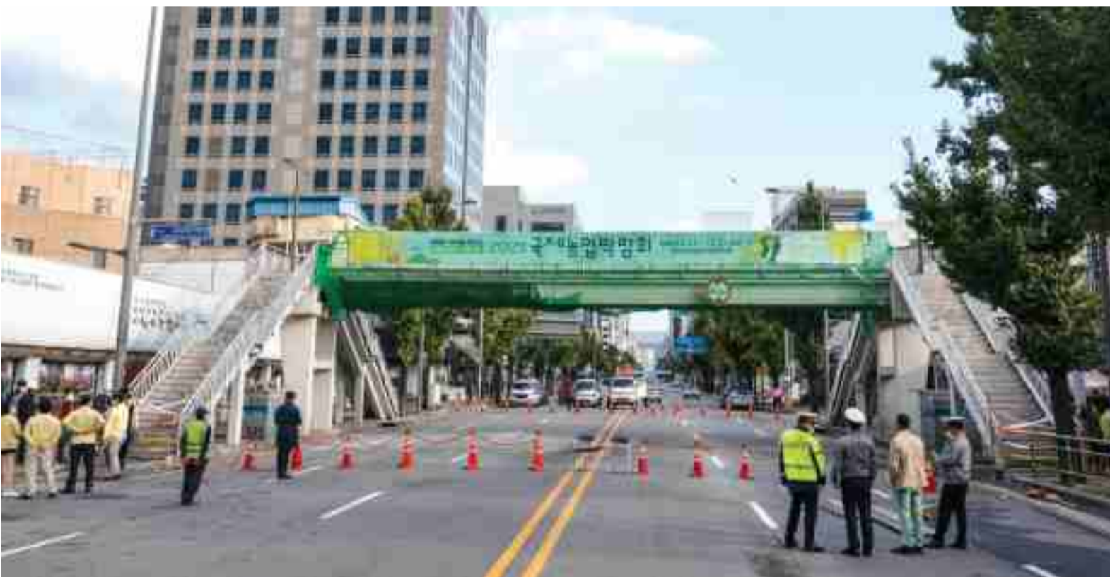
19일 오후 광주시 북구 수창초등학교 앞 육교를 긴급 철거하기 위한 사전 작업이 진행 중이다. 북구청은 지난 18일 집게차 충돌사고로 육교가 파손되면서 붕괴 위험이 있다고 판단, 육교를 긴급 철거하기로 했다. /최현배 기자choi@kwangju.co.kr
