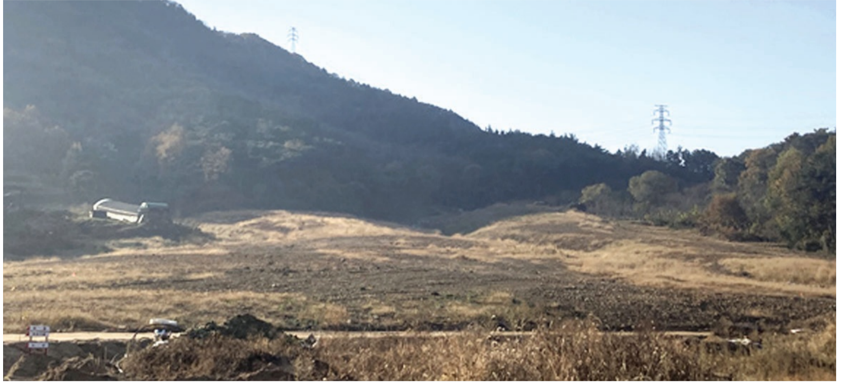
2022년 6월 매립 포화상태에 이를 것으로 전망되는 광주 남구 양과동 광역위생매립장 전경.
