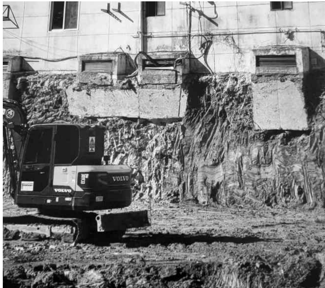
담장을 허물고 사유지를 침범해 빌딩 벽까지 터파기 공사한 모습.
