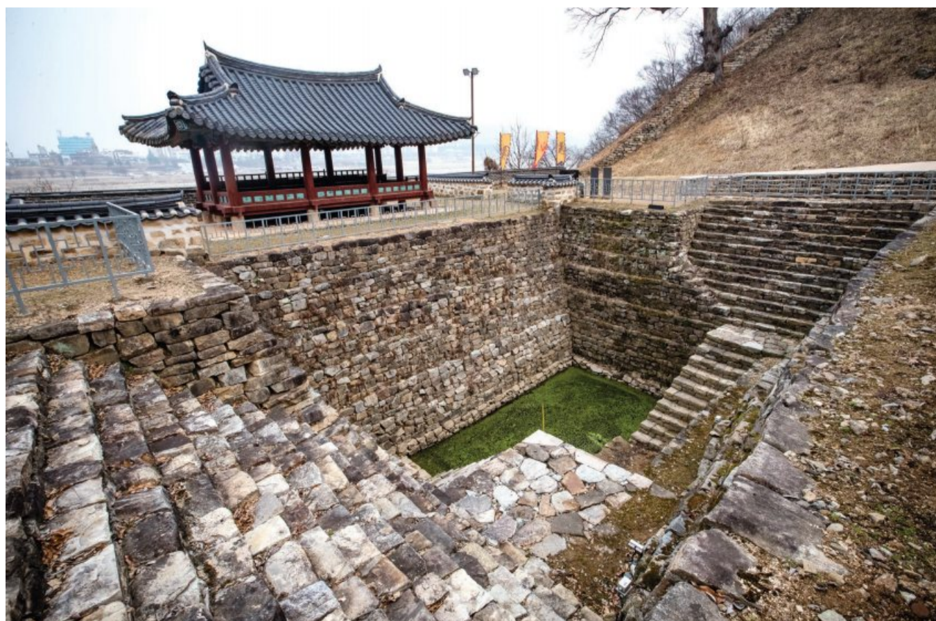
9층석탑을 거꾸로 세운 모양의 못인 연지와 만하루 뒤로 금강이 흐른다.
