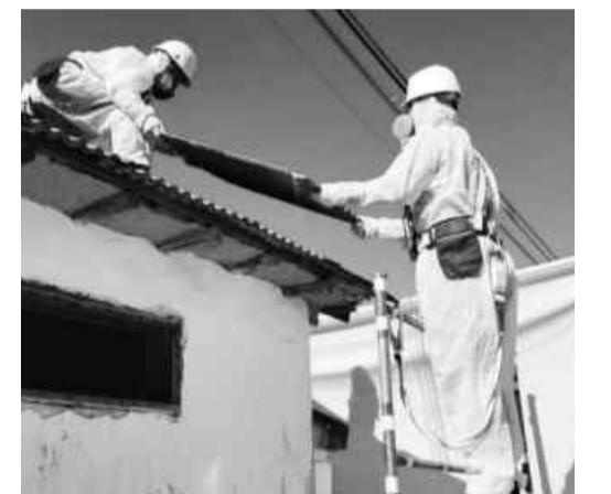
석면 슬레이트 지붕 철거작업 모습. 이성수 고창군 생태환경과장은 "앞으로 지속적인 사업 추진을 통해 군민들의 주거환경이 더욱 쾌적하고 건강하게 조성될 수 있도록 최선을 다하겠다"고 말했다. /고창=김형조 기자 khj@
