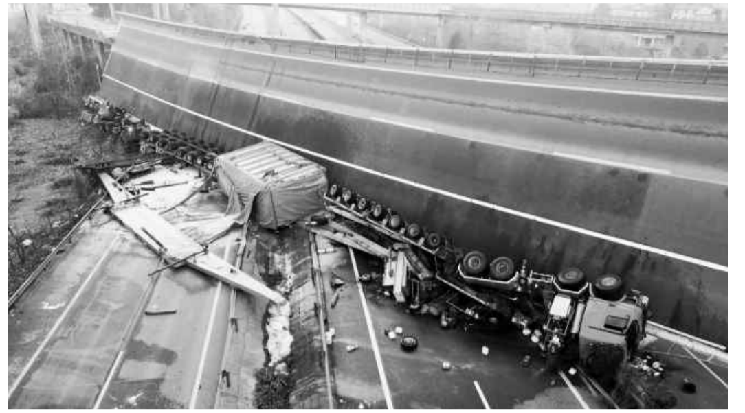
중국 후베이성 고속도로 교량 상판 붕괴 중국 후베이성 어저우시에서 지난 19일 고속도로 회전교차로 교량 상판이 옆으로 무너져내리고 그 위를 달리던 차량이 뒤집어진 채 널브러져 있다. 현지 언론은 전날 이 교량 상판이 갑자기 전복되면서 화물차 3대가 추락하고 아래 있던 승용차가 깔리면서 4명이 숨지고 8명이 부상했다고 전했다. /연합뉴스
