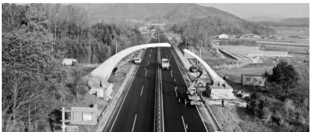
해남군 관문에 설치된 대형 공통 조형물.
