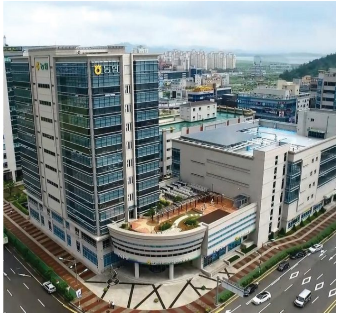
전남농협은 올해도 코로나19 사태가 지속되는 가운데 농축산물 소비 위축과 인건비·농자재 가격 상승 등 위기를 극복하기 위한 변화와 혁신을 예고했다. 무안군 삼향읍 지역본부 전경.
