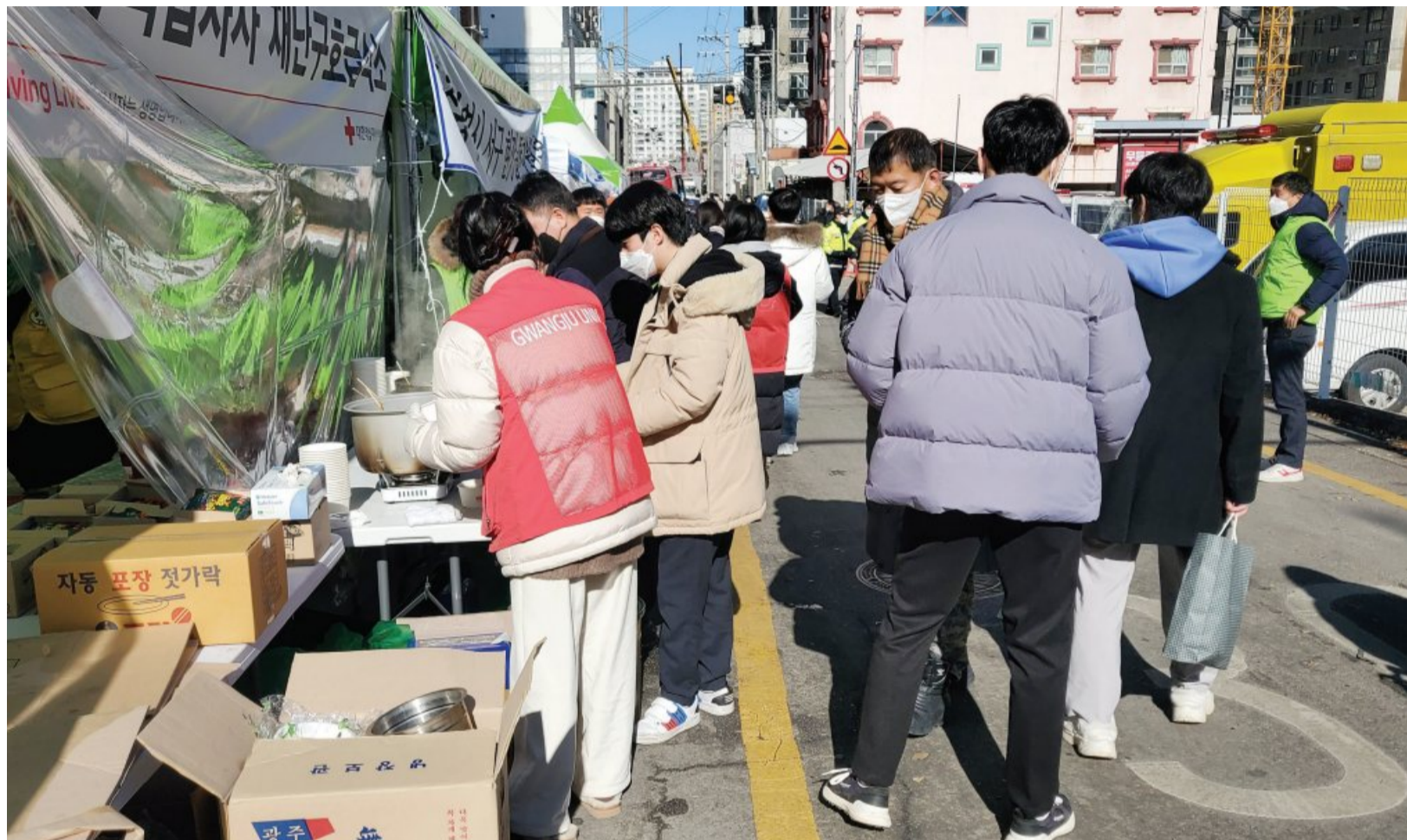
사고 현장의 온기 광주시 서구 화정동 현대산업개발 아이파크 붕괴 사고 현장에 마련된 대한적십자사 재난구호급식소에 자원봉사자들의 발길이 이어지고 있다. 광주대 교직원과 학생들은 지난 14일 소방대원과 현장 근로자 등에게 핫팩 수 백개와 150인분의 어묵국을 준비해 제공했다. /최현배 기자 choi@kwangju.co.kr
