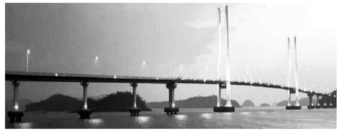
선박 통항로에 설치된 교량의 항로표지시설.
