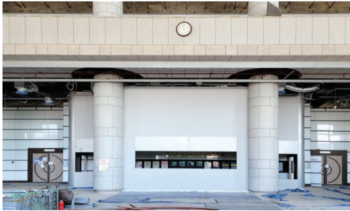
리모델링 공사가 진행중인 대극장 로비. 이곳에는 티켓박스가 새롭게 생길 예정이다.
