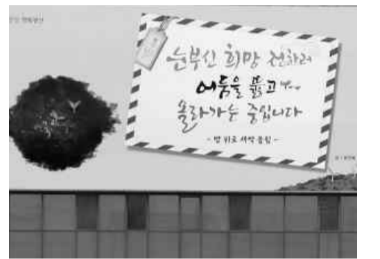
광산구청사 외벽에 설치된 '광산행복돋움판'
