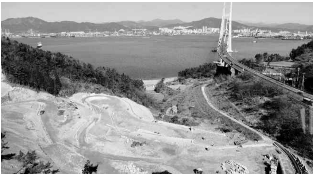
여수시 묘도동 조명연합수군 테마 역사공원 조성 현장.
