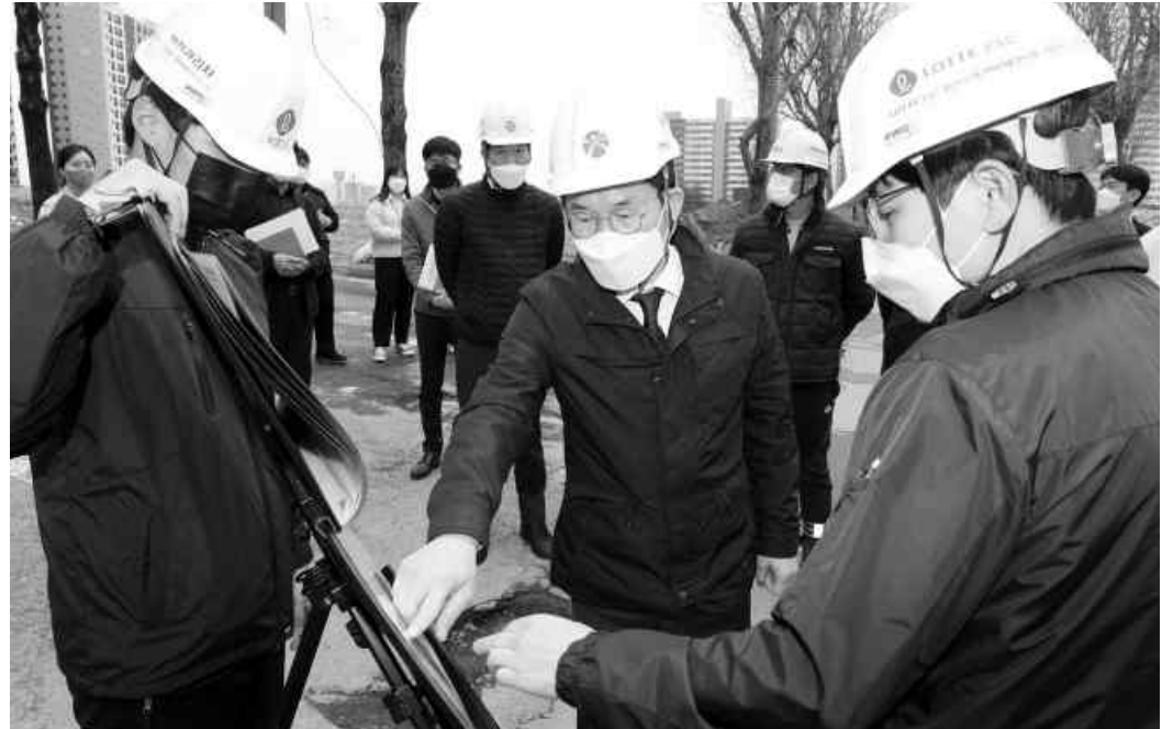
주택철거 공사현장 점검 문영훈(가운데) 광주시 행정부시장이 최근 광산구 신가동 주택재개발비사업 현장을 방문해 주택철거 현장을 점검하고, 관계자들에게 철저한 안전공사를 당부했다.
