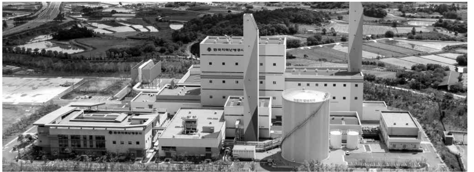
29일 나주 빛가람혁신도시의 SRF 열병합발전소가 시험가동 4년6개월만에 정상 가동에 들어갔다. 사진은 나주 SRF 열병합발전소 전경 모습. <광주일보 자료사진>
