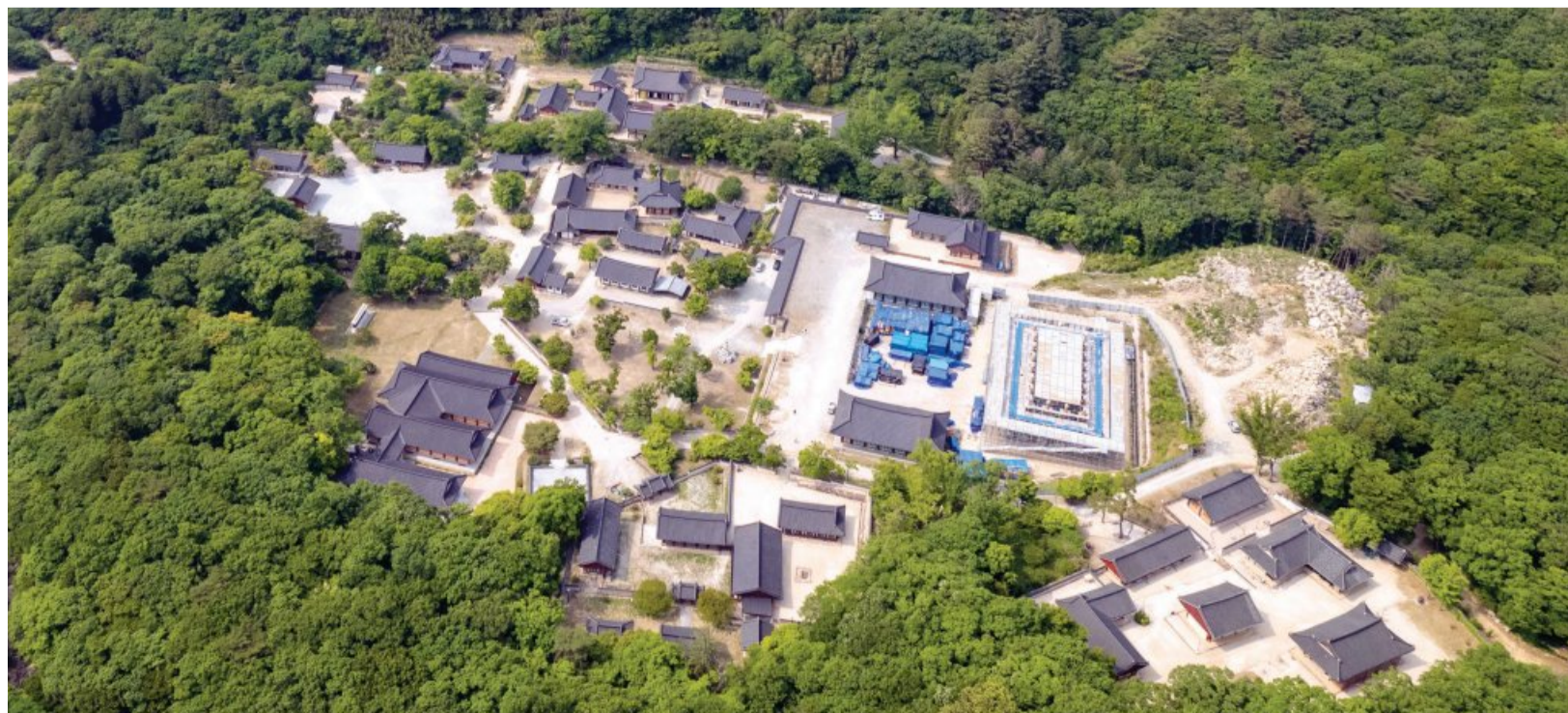
해남읍~대흥사 간 지방도 확·포장 사업으로 해남의 대표적인 관광명소인 두륜산도립공원을 비롯한 대흥사권 관광 활성화에 큰 역할을 할 것으로 기대된다. 사진은 해남 천년고찰 대흥사 전경.
