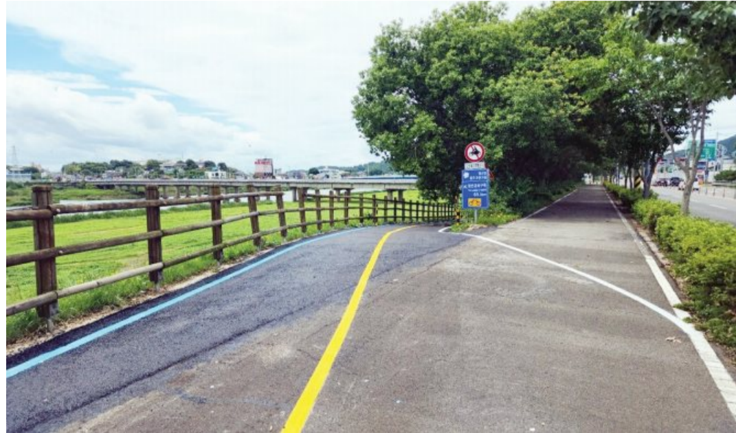
나주시 영산강 둔치 자전거길 400m구간의 아스팔트 재포장 공사 완료 모습.
